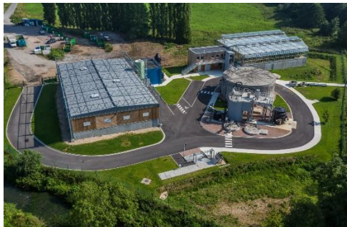
Station d'Épuration de Brionne
