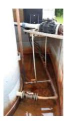
Il s'agit de procéder au nettoyage et démantèlement de la cuve actuelle et au remplacement de celle-ci par une cuve double peau ainsi qu'au déplacement du coffret contenant les pompes
