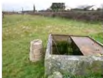
Regard avant station
