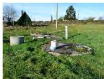
Ouvrages de la station
