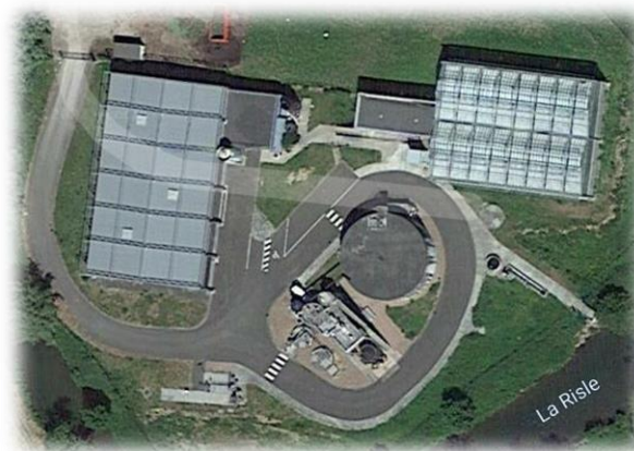
Vue aérienne de la station de Bionne
