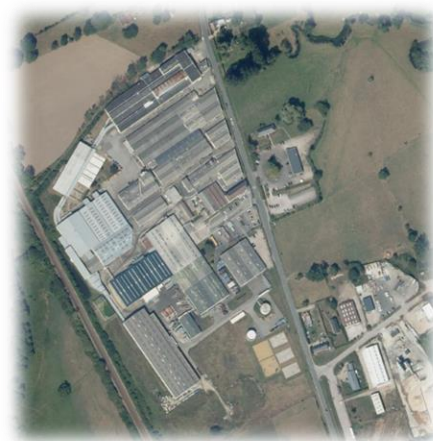
Vue aérienne du site d'Howa Tramico
