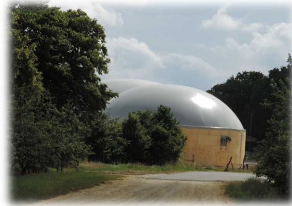
Unité de méthanisation à Saint-Pierre-du-Mesnil
