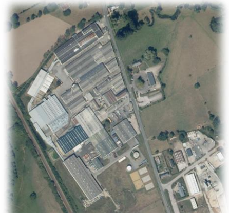
Vue aérienne du site d'Howa Tramico
