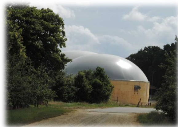
Unité de méthanisation à Saint-Pierre-du-Mesnil
