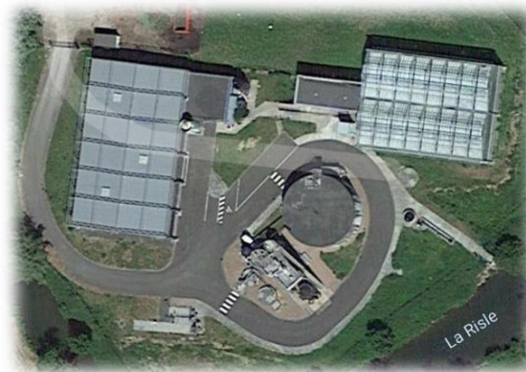
Vue aérienne de la station de Bionne
