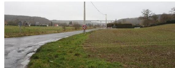
Le Buhot – pont de l'A28
